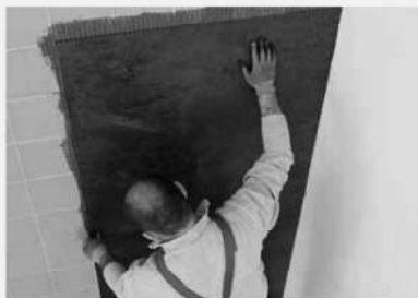
fig.38 Aplikacja Płyty / Application of the slab.
