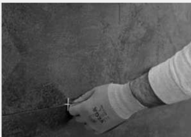
fig.37 Aplikacja z krzyżakami dystansowymi / Application with spacers.
