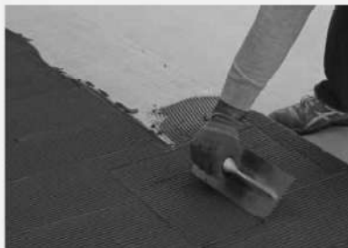
fig.36 Aplikacja kleju na płycie. / Application of the adhesive on the slab back side.
