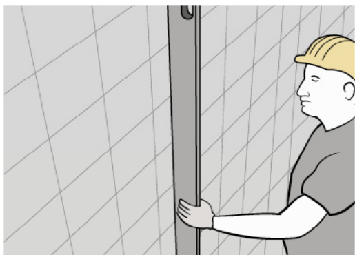
Sprawdzenie płaskości istniejącej okładziny
