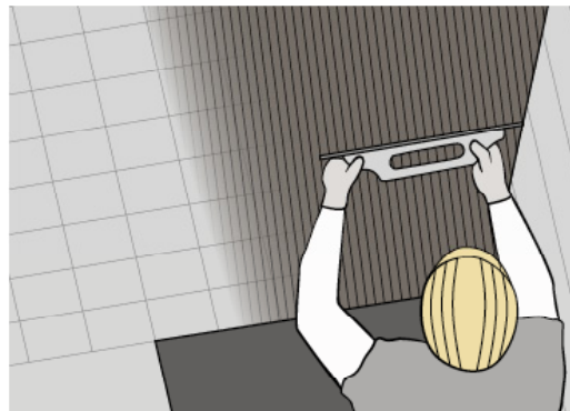
Rozprowadzenie kleju na istniejącą okładzinę
