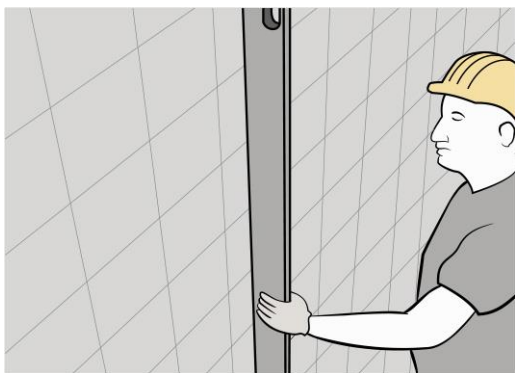
Проверьте плоскость существующего основания / Check planarity of the existing substrate
